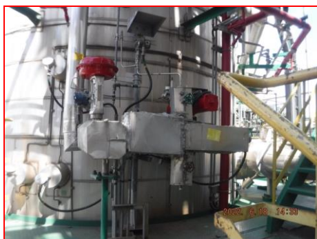
ภาพที่ 2.2-52 Shut Down Valve และ Safety Valve
