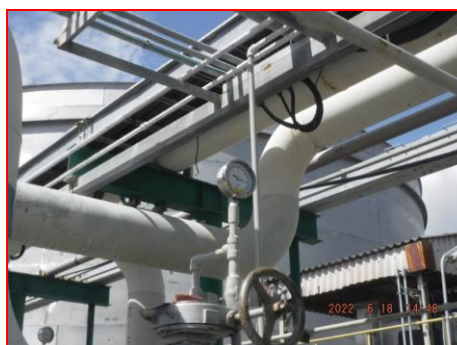
ภาพที่ 2.2-21 Pressure Gauge
