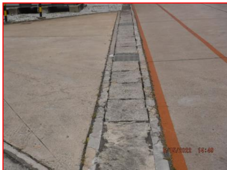
ภาพที่ 2.2-22 รางระบายน้ำฝนภายในโรงงาน
