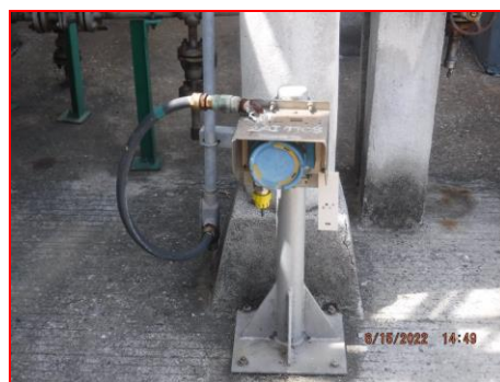
ภาพที่ 2.2-51 Gas Detector
