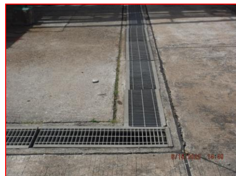
ภาพที่ 2.2-25 รางระบายน้ำฝนปนเปื้อนภายในโรงงาน
