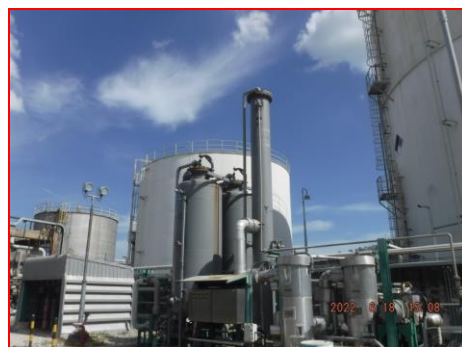
ภาพที่ 2.2-6 หอดูดซับสารอินทรีย์ระเหยง่าย (VRU)
