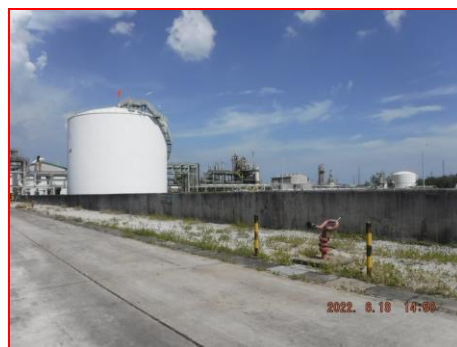
ภาพที่ 2.2-53 กำแพงกันสารเคมี เพื่อป้องกันสารเคมีหกรั่วไหล
